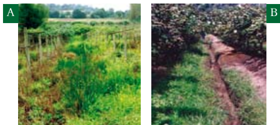
Figura 6.1. Pomares de actinídea com plantas mortas por deficiente drenagem (A) e com instalação de drenagem superficial, em pomar já implantado (B).
