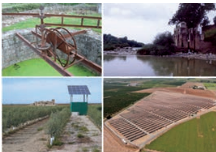
Figura 7. Izda. Arriba: Noria de sangre en Monsanto (Portugal). Dcha. Arriba: Las Grúas, El Carpio (Córdoba). Izda. Abajo: Paneles solares para riego de olivar en La Carlota (Córdoba). Dcha. Abajo: Planta solar en la Zona Regable Valle Inferior (Sevilla) (Fotografía de la Comunidad de Regantes Valle Inferior).
